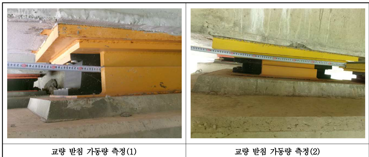
【사진 7.3.40】교량받침 이동량 측정
