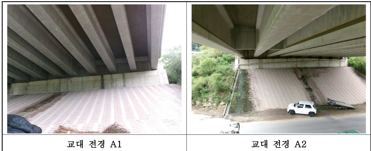
【사진 7.3.8】 교대 전경
