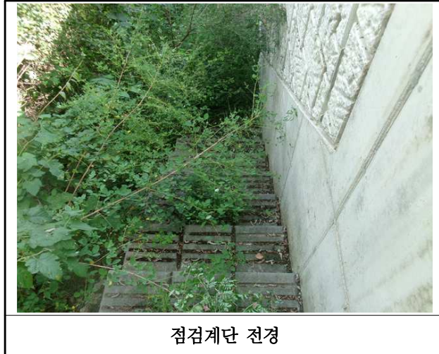
【사진 7.3.25】 교량 점검시설 전경
