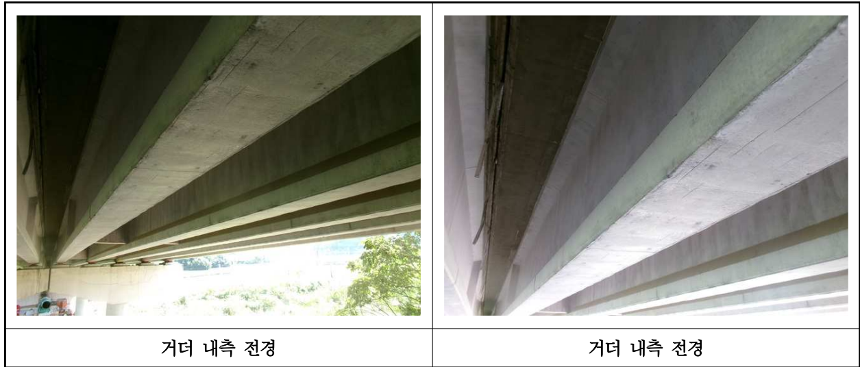
【사진 7.3.29】 거더 전경
