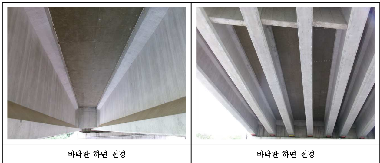
【사진 7.3.2】 바닥판하면 전경
