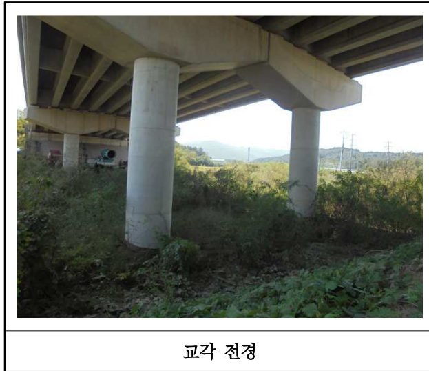
【사진 7.3.10】 교각 전경
