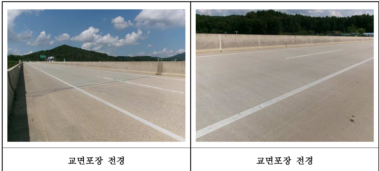
【사진 7.3.44】 교면포장 전경
