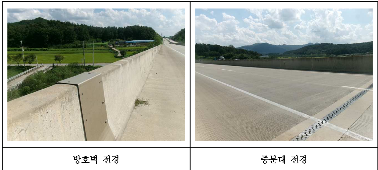
【사진 7.3.23】 방호벽 및 중앙분리대 전경
