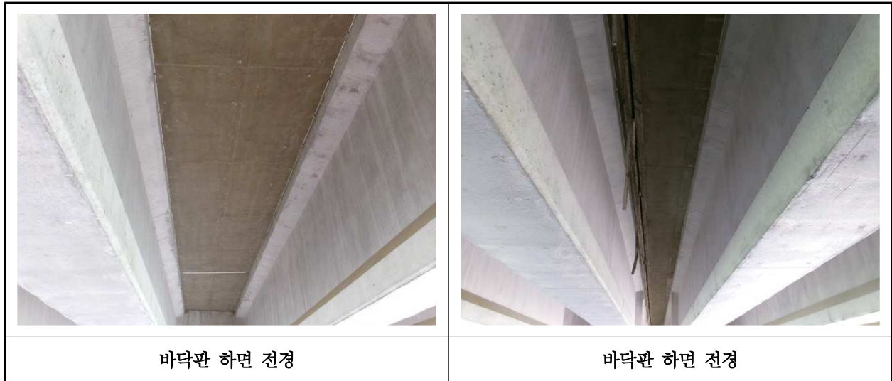
【사진 7.3.27】 바닥판하면 전경
