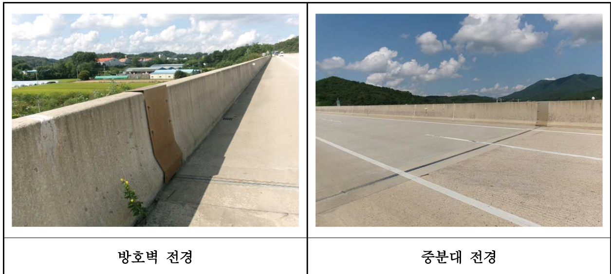
【사진 7.3.48】 방호벽 및 중앙분리대 전경
