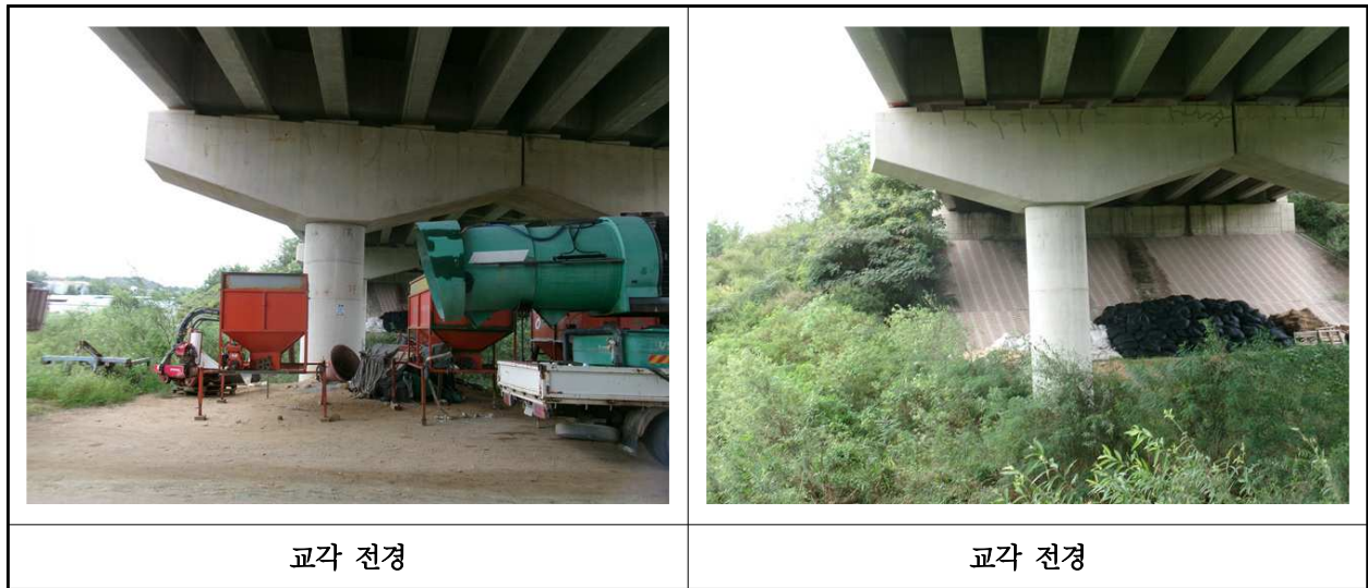
【사진 7.3.35】 교각 전경
