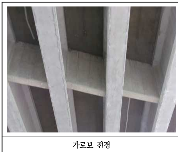
【사진 7.3.31】 가로보 전경
