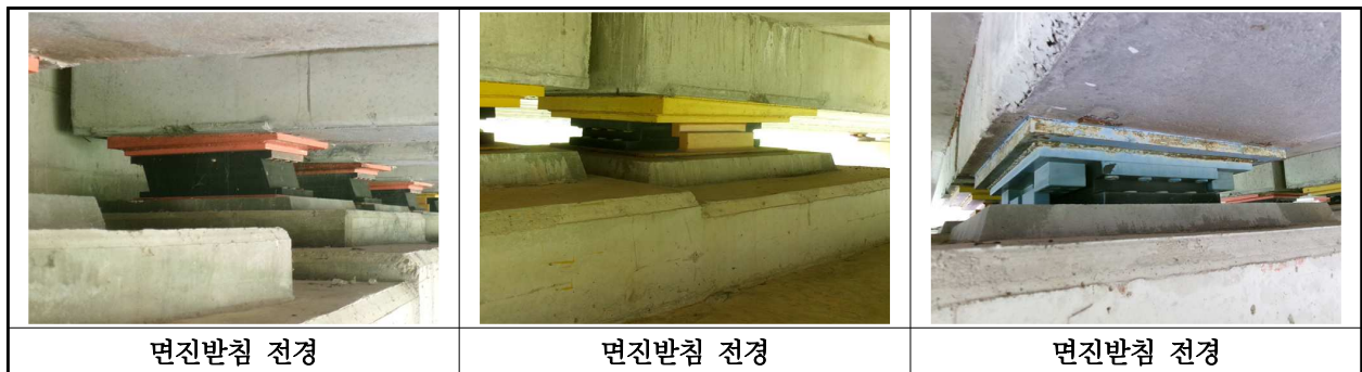
【사진 7.3.37】 교량받침 전경
