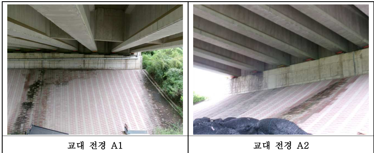
【사진 7.3.33】 교대 전경
