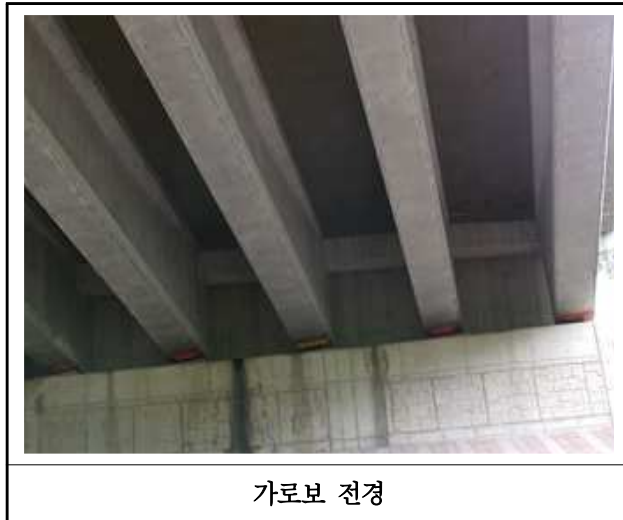
【사진 7.3.6】 가로보 전경
